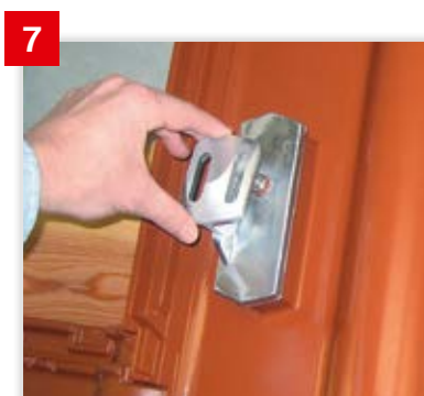
7 Anschließend den montierten Solarträgeraufsatz nach Dachneigung ausrichten.
