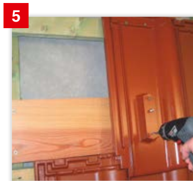
5 Die Alu-Solar-Trägerpfanne mit zwei Edelstahlschrauben in die Holzbohle befestigen. Die Länge der Schrauben ist bauseits zu bestimmen. Die Trägerpfanne hat keinen direkten Kontakt zur Holzbohle.
