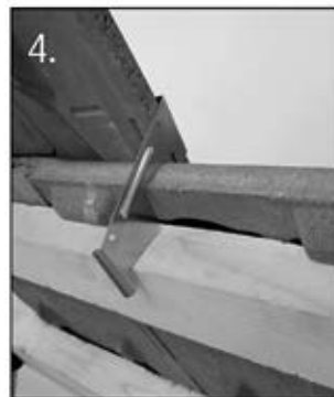
4. Klammer sitzt mit dem Ende hinter der Lattung. Fertig!
